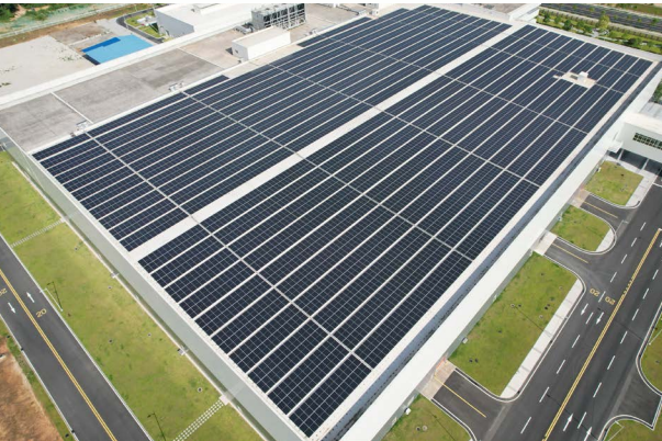
HTWO 广州工厂屋顶光伏系统
