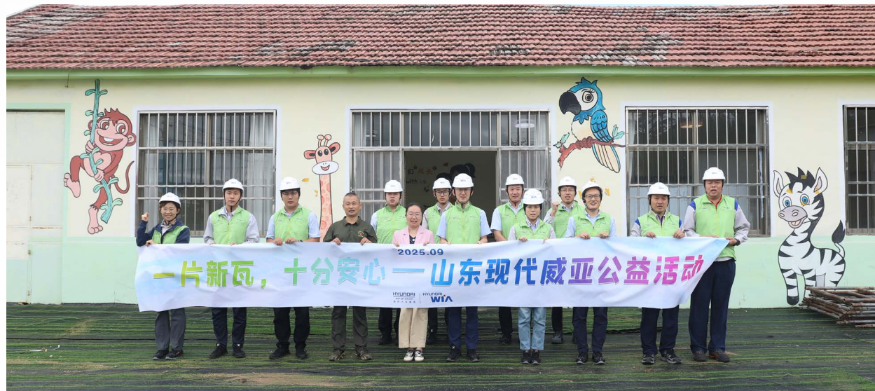
山东现代威亚组织 15 名志愿者赴山东省日照市五莲县东洪河村“童心驿站”，为教室更换屋顶瓦片，切实改善孩子们的学习环境
