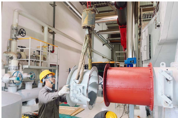
现代商用车开展原动室燃气锅炉低氮改造
