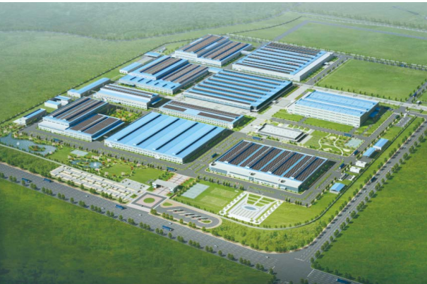
山东现代威亚太阳能光伏发电站
